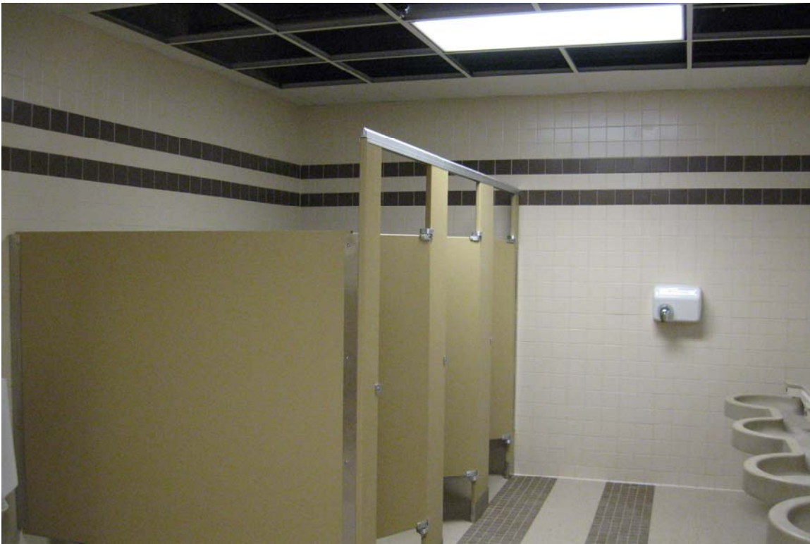
Commons Area Restroom
